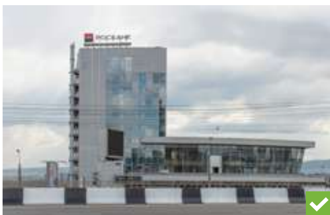
Высота крышной конструкции 3 м.
