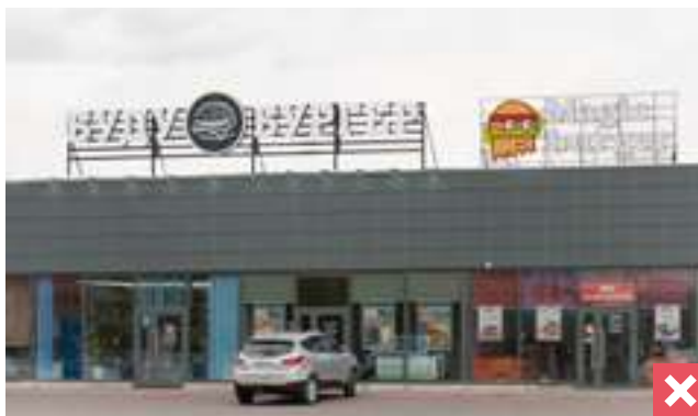
Высота крышной конструкции более 0,8 м.
