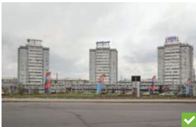
Высота крышной конструкции 4 м.
