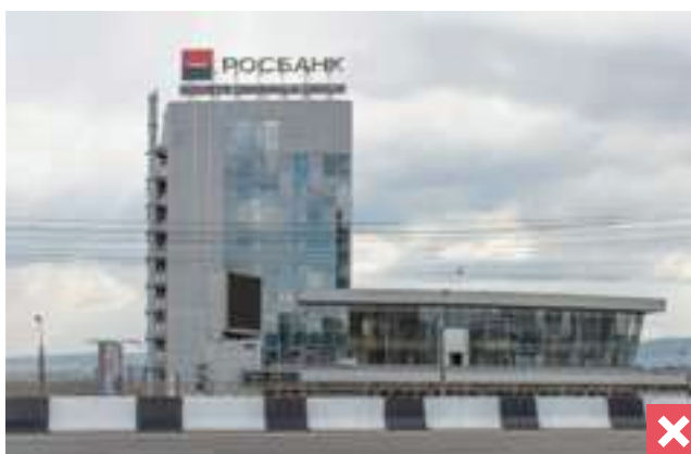
Высота крышной конструкции более 3 м.
