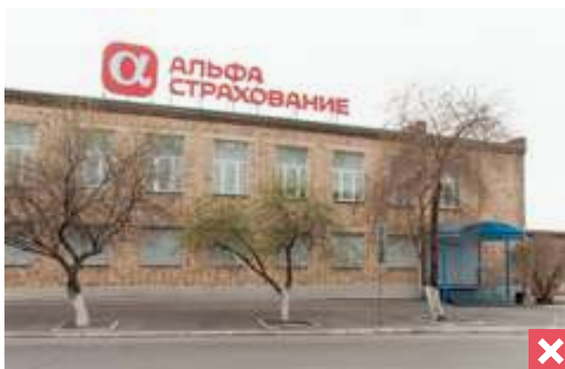
Высота крышной конструкции более 1,5 м.
