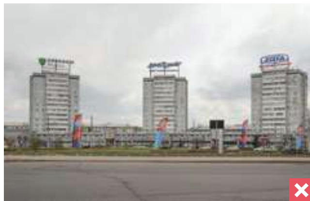
Высота крышной конструкции более 4 м.
