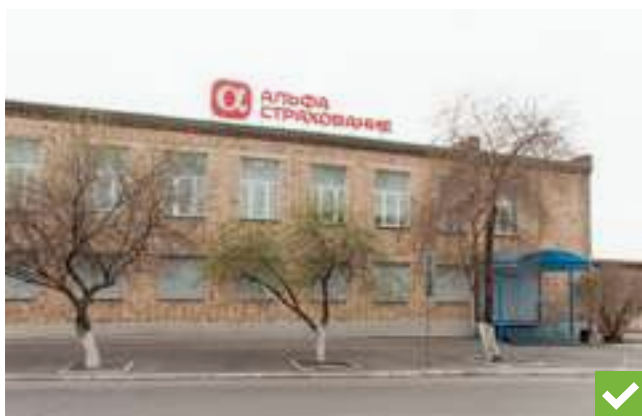
Высота крышной конструкции 1,5 м.
